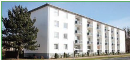
Sanierte Frontseite am Haus Kattowitzer Str. 196
