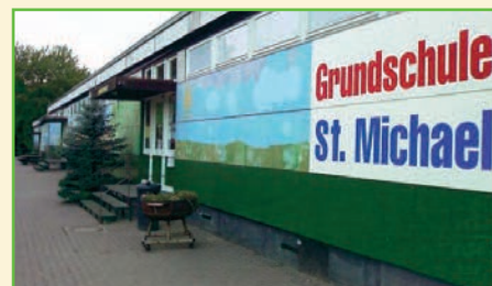
Trakt der Grundschule St. Michael
