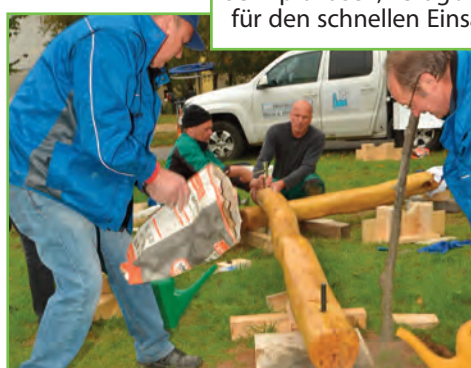
Sehr praktisch, Fertigbeton für den schnellen Einsatz.
