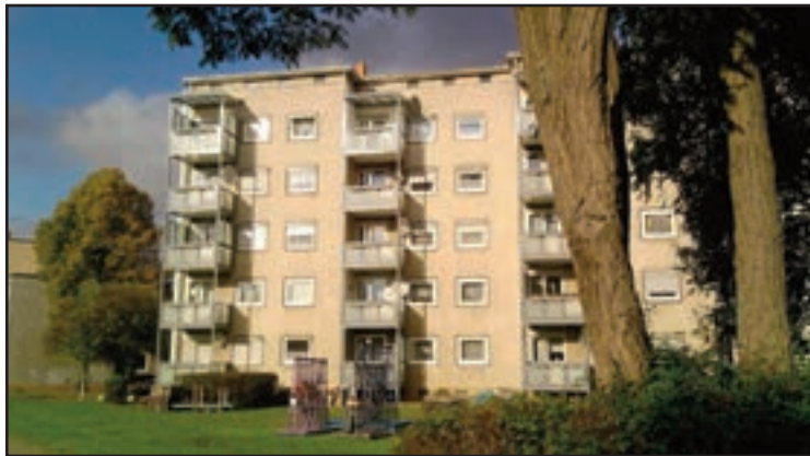
Kurz vor der Fertigstellung, die neuen Balkone am Gebäudekomplex Sudermannstr. 2-4. Gefördert aus Mitteln Stadtumbau West.
