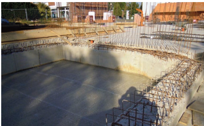
Bodenplatten wurden gegossen, Aussenwand Neißstraße wird hochgezogen, September 2012
