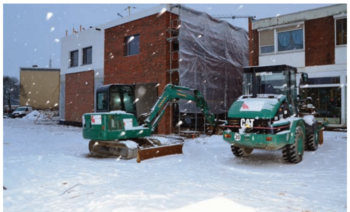
Wetterbedingt wurden die Arbeiten im Dezember eingestellt, 12. Dezember 2012
