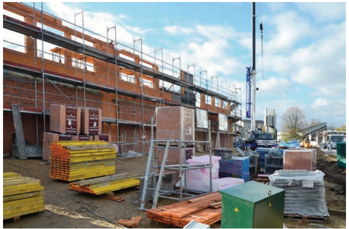
Aussenfassade wird noch im Rohbau verklindert, November 2012
