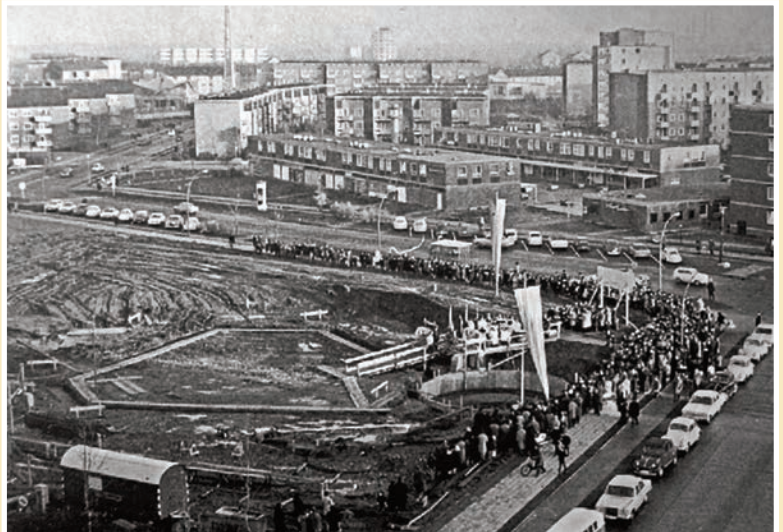
Grundsteinlegung der St. Elisabeth Kirche am 19.11.1967. Im Hintergrund das EKZ Neißestr. / Gesemannstr., das jetzt modernisiert wird.
