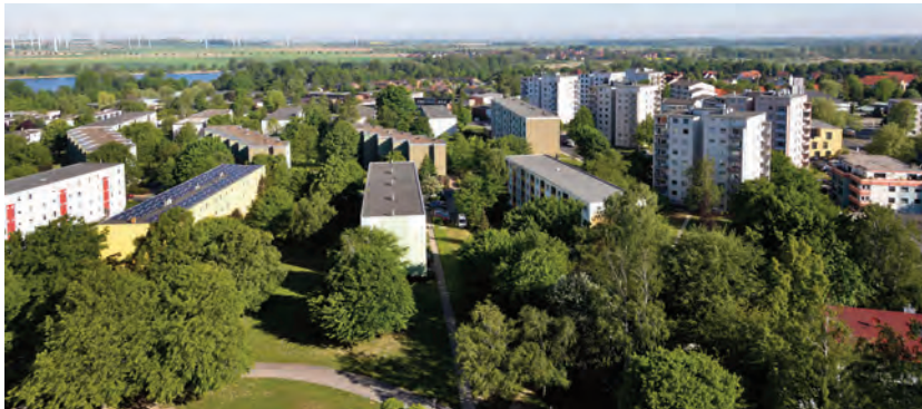
SeeViertel mit Blick in Richtung Stromtal und Kieselgrund
