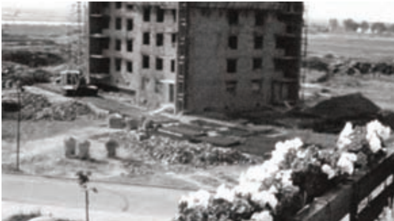
Rohbau des Hochhauses Riesentrapp 24 im Jahr 1962
