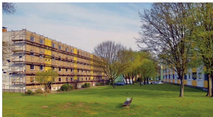
Links, Beginn der Sanierung 2017, Gebäude Stromtal 37 - 43 Rechts, Gebäude Stromtal 29 - 41, saniert 2009
