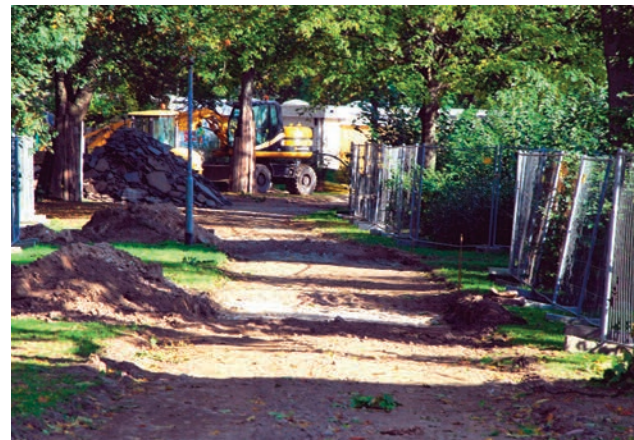
Bauarbeiten am Seeweg
