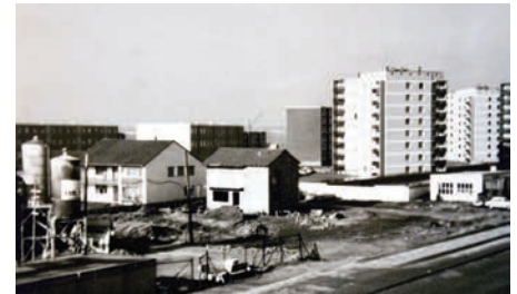
Baustelle EFB 1965 an der Kattowitzer Str.
